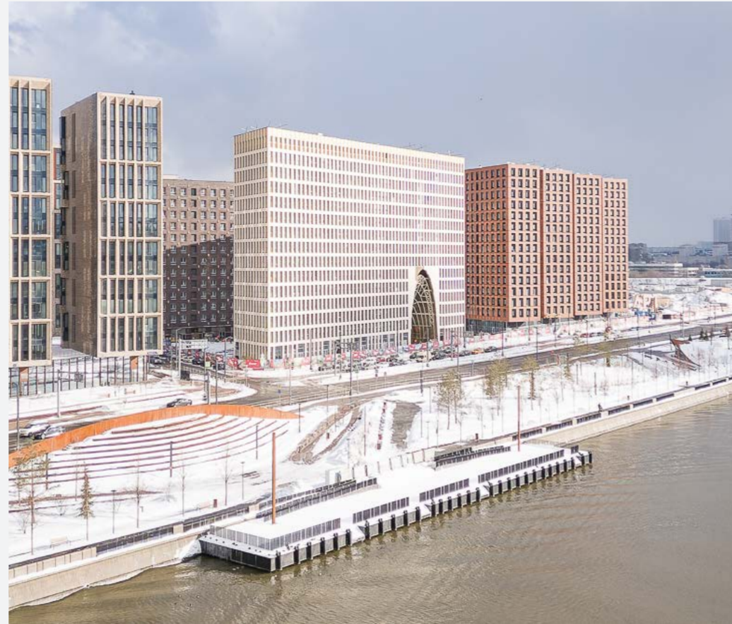
Ход строительства, март 2023 г.
