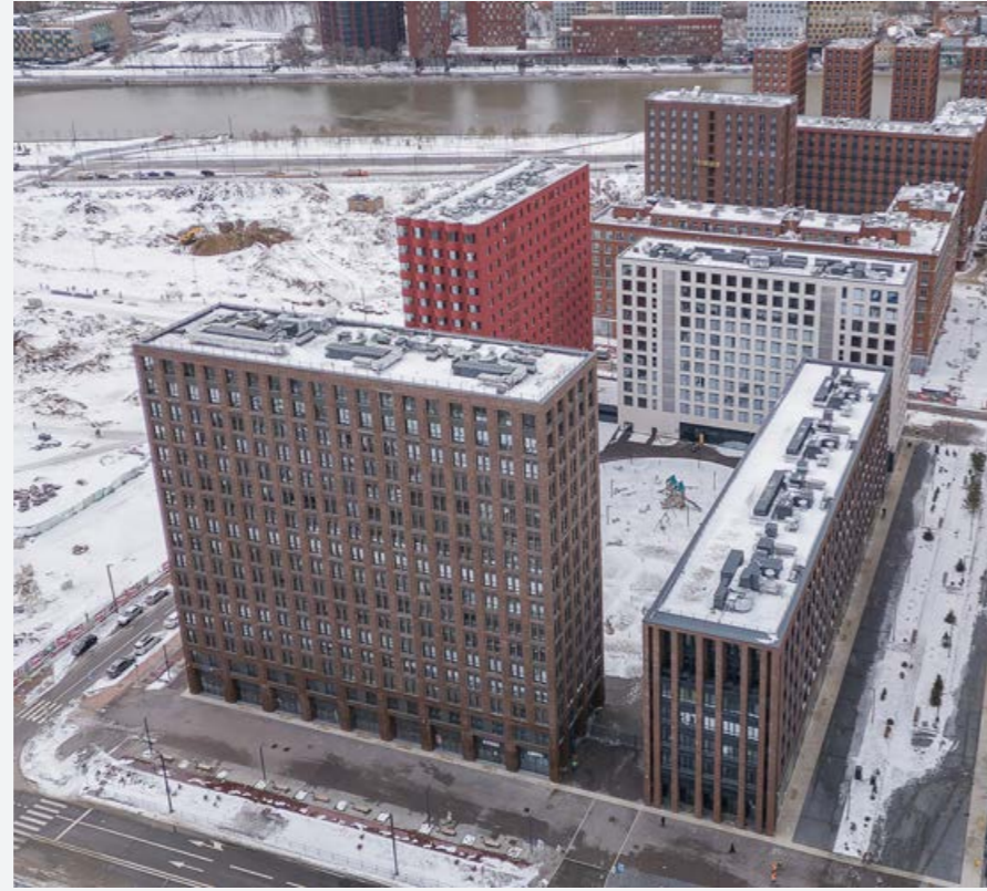
Ход строительства, март 2023 г.
