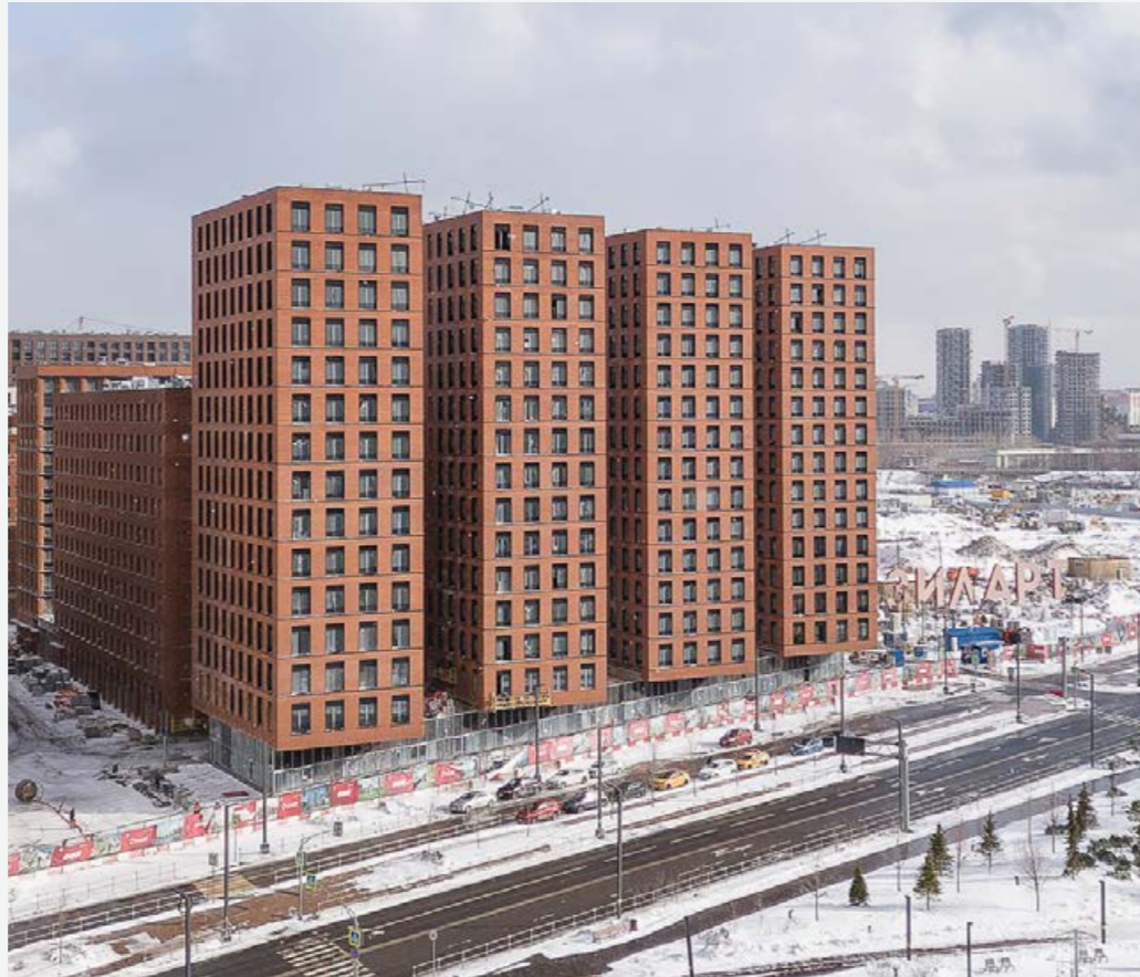
Ход строительства, март 2023 г.
