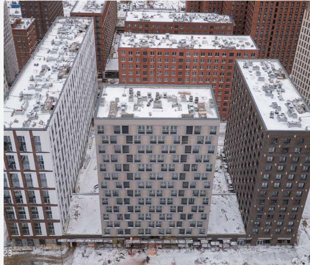
Ход строительства, март 2023 г.
