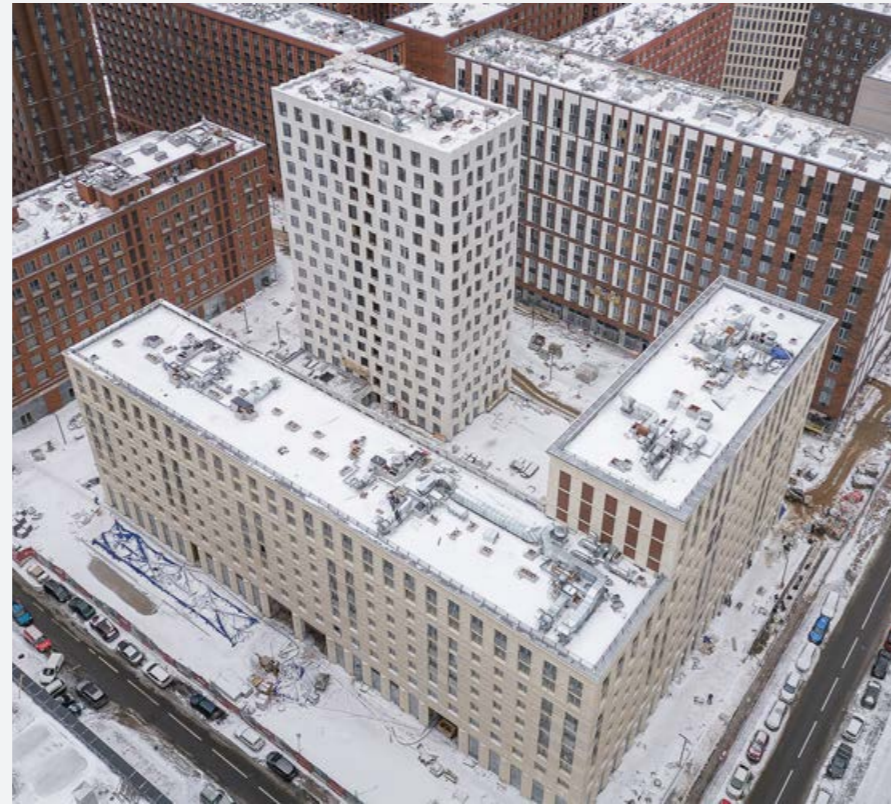
Ход строительства, март 2023 г.
